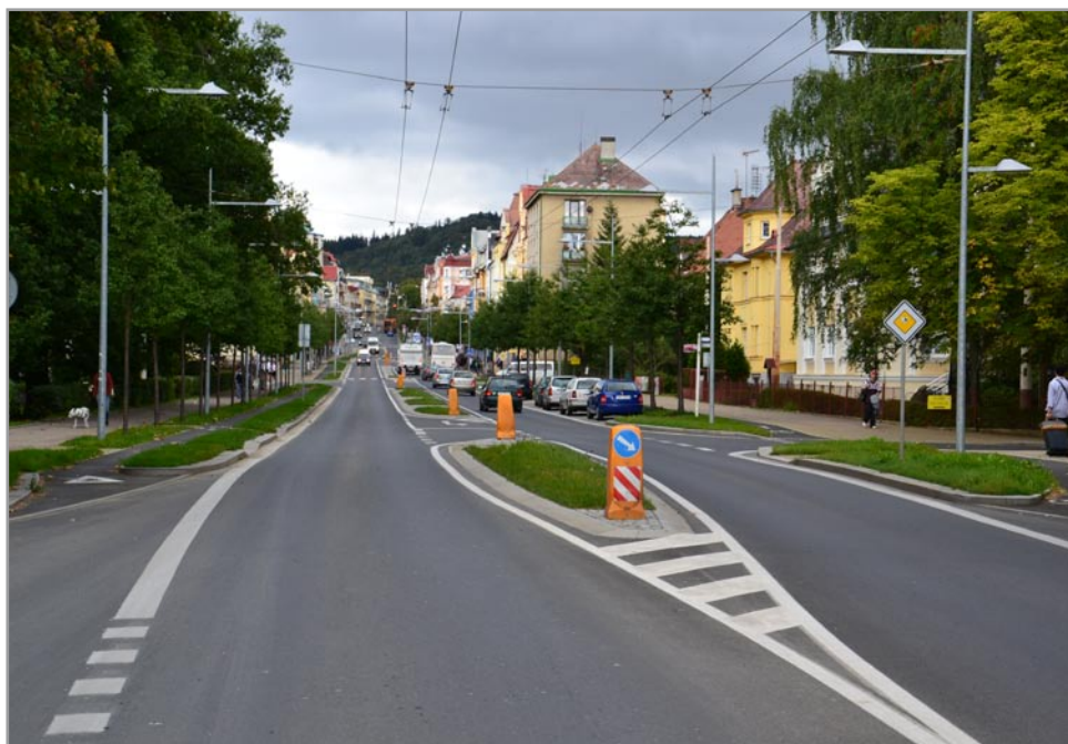
Obrázek 12: Dělicí ostrůvek při ulici U Nemocnice - první zklidňující opatření při jízdě směrem od Plané (Úšovické křižovatky) na upraveném průtahu ulice Hlavní třída. ▲
