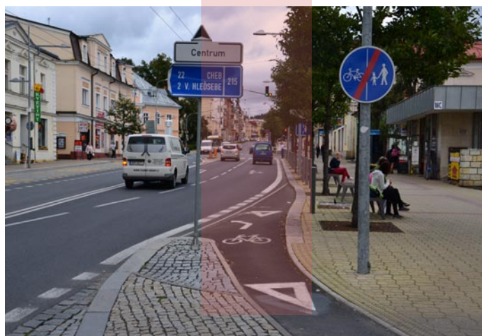
Obrázek 18: Sjezd cyklostezky do jízdního pruhu před Chebskou křižovatkou. ▲
