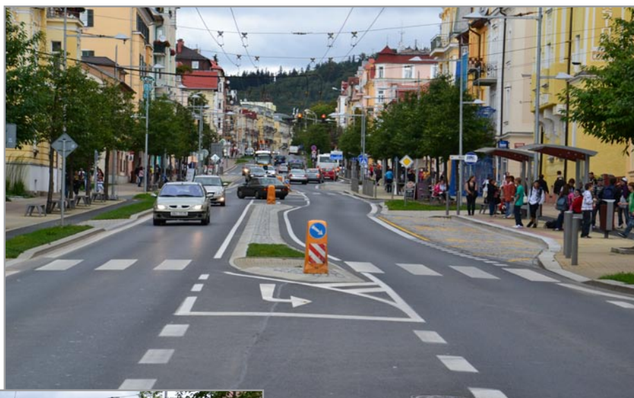
Obrázek 10: Dělicí pás mezi křižovatkami Hlavní třídy s ulicí Lužická a Komenského pohledem směrem k Chebské křižovatce. Na snímku patrné jednostranné směřové vychýlení pásu díky vychýlené ploše zastávky. ▲
