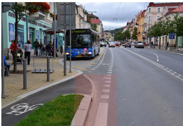
Obrázek 13: Vedení cyklostezky (ve směru od Chebské křižovatky k Úšovické křižovatce) podél zastávky hromadné dopravy v samostatném pruhu s nájezdem na vlastní těleso. ▲
