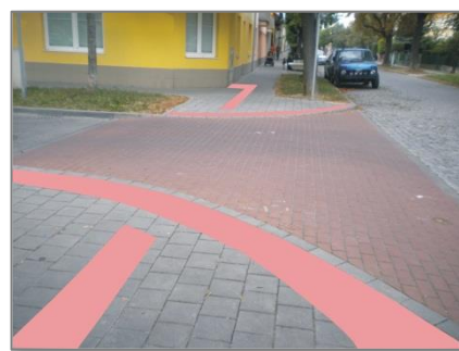
— Obrázek 63: Místo pro přecházení – chybí navedení nevidomého do směru přecházení (odsazený signální pás), varovný pás podél obrubníku má končit až v místě, kde je výškový rozdíl mezi vozovkou a chodníkem 80 mm (Brno).
