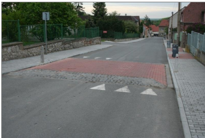
Obrázek 41: Dlouhý zpomalovací práh – upozornění na výškovou změnu na komunikaci provedeno vodorovným dopravním značením č. V17 (Trojúhelníky), (Rudná u Prahy)
