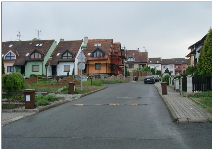
Obrázek 40: Zpomalovací práh – dopravní zařízení č. Z 12 (Krátký příčný práh), (Uherské Hradiště-Mařatice)
