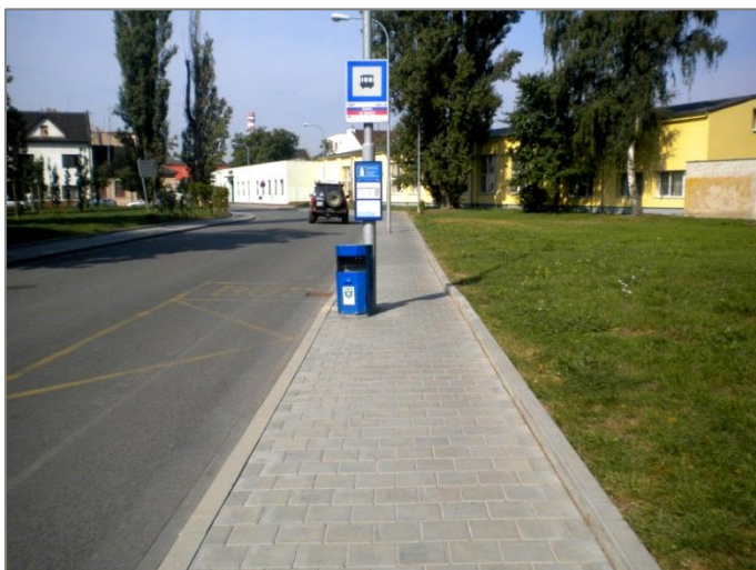
→ Obrázek 62: Chybné řešení hmatné dlažby na přechodu pro chodce – není jasná funkce signálního pásu vedeného napříč chodníkem. V průchozím prostoru podél vodící linie (zvýšený obrubník) je umístěna překážka (Brno).
