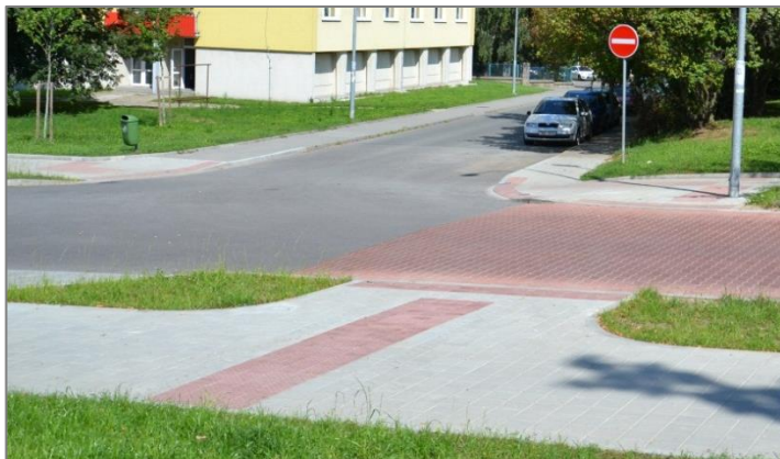
Obrázek 30: Vhodně označené místo pro přecházení (Brno)
