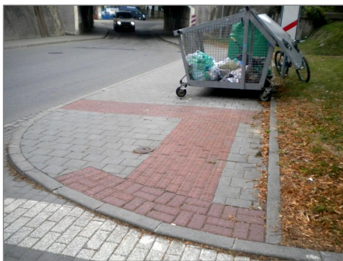
— Obrázek 63: Místo pro přecházení – chybí navedení nevidomého do směru přecházení (odsazený signální pás), varovný pás podél obrubníku má končit až v místě, kde je výškový rozdíl mezi vozovkou a chodníkem 80 mm (Brno).
