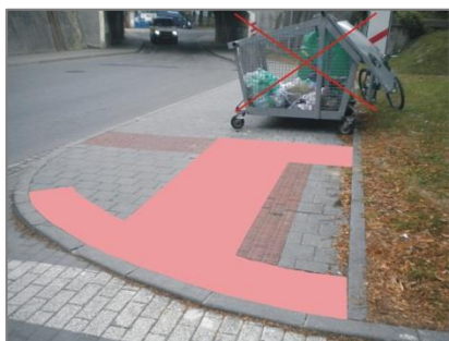
→ Obrázek 62: Chybné řešení hmatné dlažby na přechodu pro chodce – není jasná funkce signálního pásu vedeného napříč chodníkem. V průchozím prostoru podél vodící linie (zvýšený obrubník) je umístěna překážka (Brno).
