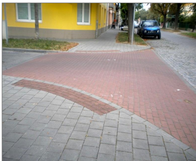
— Obrázek 63: Místo pro přecházení – chybí navedení nevidomého do směru přecházení (odsazený signální pás), varovný pás podél obrubníku má končit až v místě, kde je výškový rozdíl mezi vozovkou a chodníkem 80 mm (Brno).
