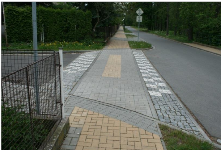
Obrázek 18: Místo pro přecházení v kombinaci s dlouhým zpomalovacím prahem (Slatiňany)
