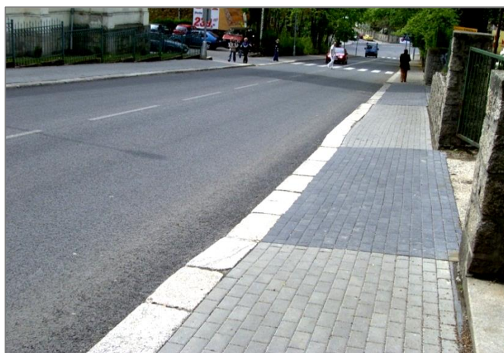
→ Obrázek 71: Chybí varovný pás na rozhraní mezi chodníkem a vozovkou v místě snížené obruby (Liberec).
