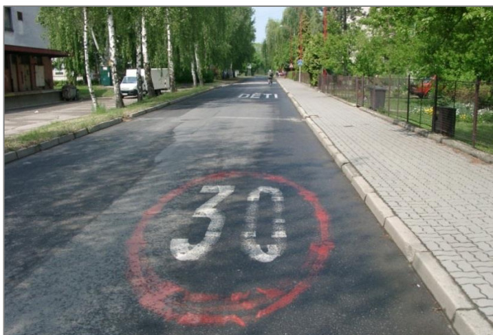
Obrázek 13: Připomenutí plošného omezení rychlosti vodorovným dopravním značením č. V 15 (Nápis na vozovce), (Uherské Hradiště)
