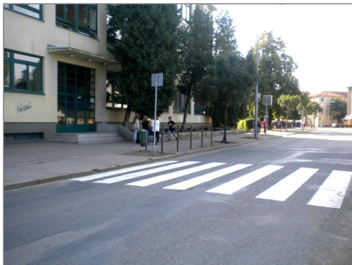
→ Obrázek 59: V místě výjezdu z garáže není dodržen požadavek na průchozí pás (šířka min. 0,9 m ve sklonu max. 2 %), chybí varovný pás podél snížené části chodníku (Brno).
