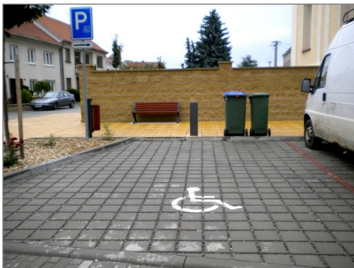
→ Obrázek 68: Parkovací stání vyhrazené pro osoby se zdravotním postižením: vsakovací dlažbu s velkými spárami nelze použít, pro osoby na vozíku, popř. s jinými kompenzačními pomůckami (Brno).
