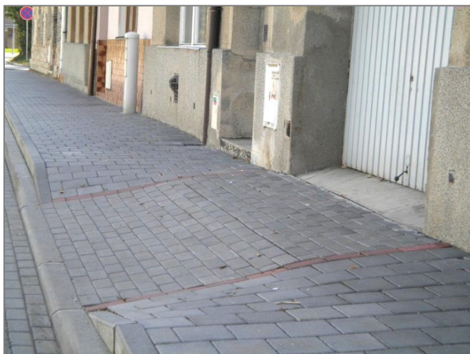
← Obrázek 60: Na chodníku není dodržen požadavek na průchozí pás šířky min. 0,9 m (Brno).
