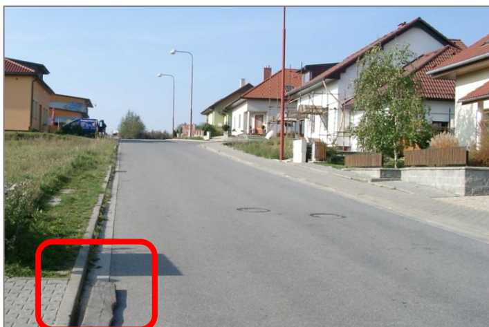
Obrázek 26: Podélný a příčný sklon (Velké Meziříčí)
