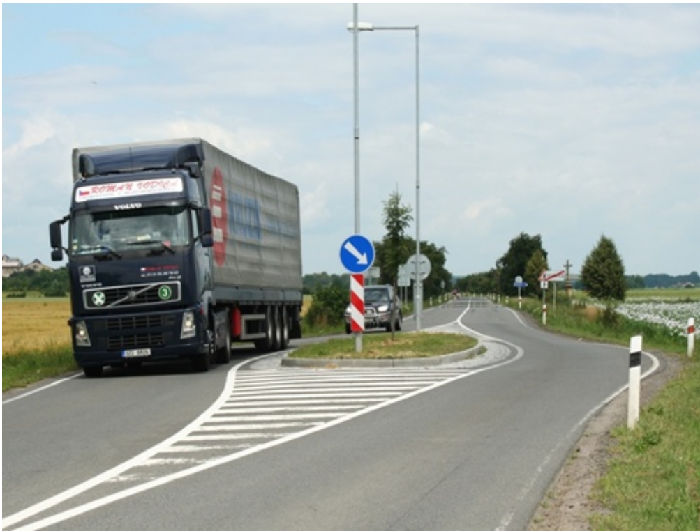
Obr. 2: Ochranný ostrůvek pro podporu přecházení – Prostějov.
