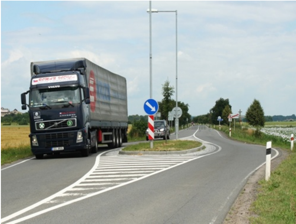
Obr. 2: Ochranný ostrůvek pro podporu přecházení – Prostějov.
