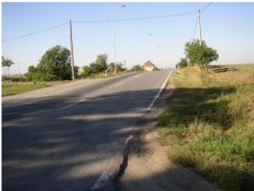
Obr. 19: Nedostatečný dohled na hlavní silnici (II/430, Rousínov)
