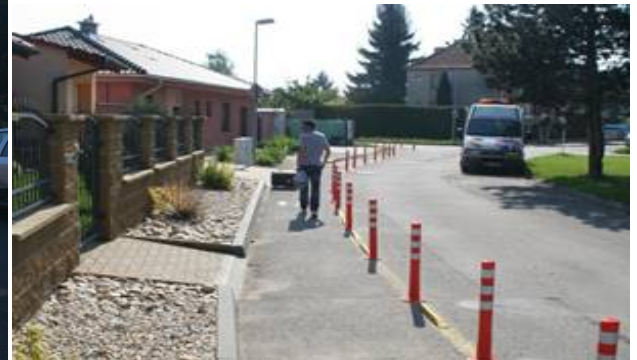
Obrázek 11. Břeclav – krátce po osazení
