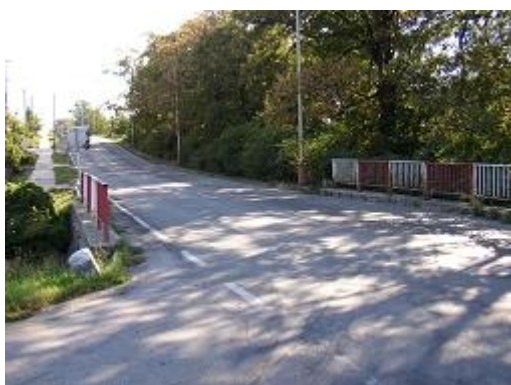
Obr. 18: Nákladní automobil zakrytý značkou (II/430, Rousínov)
