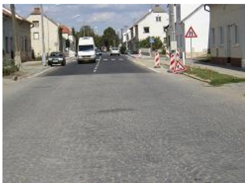
Obr. 11: Chybějící připojovací pruh (D 1, Rohlenka)
