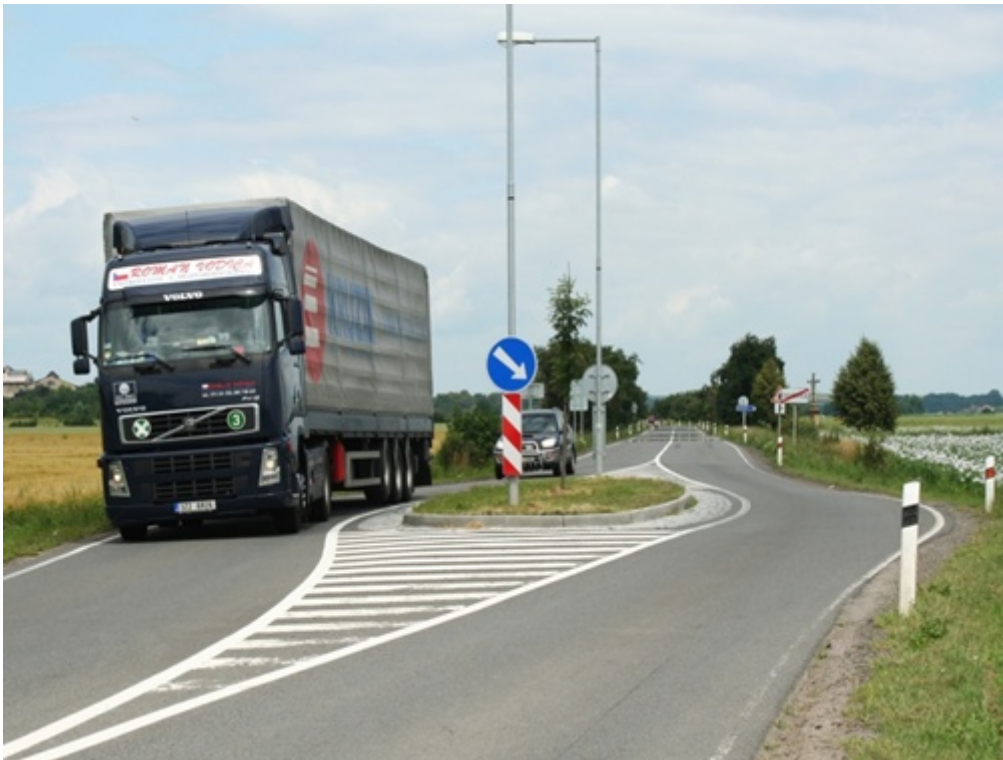
Obr. 2: Ochranný ostrůvek pro podporu přecházení – Prostějov.
