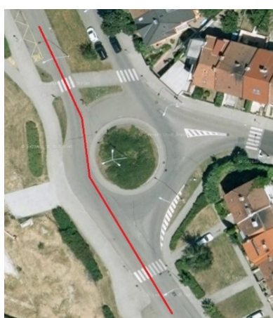
obr. 03. Nevhodně navržená OK – možný přímý průjezd
