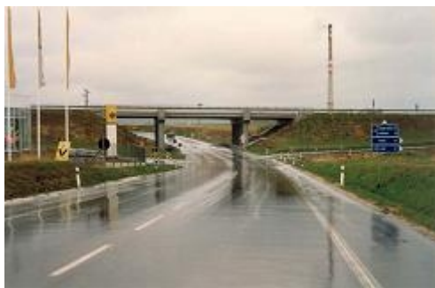
Obr. 1: Dříve nehodová zatáčka na okraji Písku (den)
