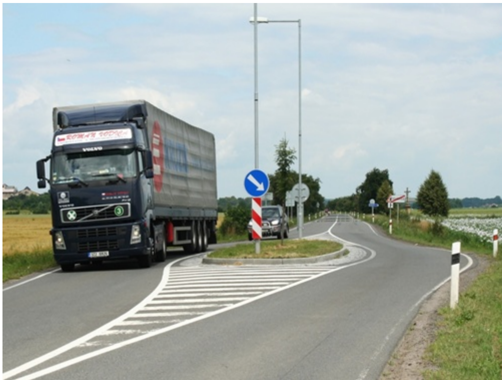
Obr. 2: Ochranný ostrůvek pro podporu přecházení – Prostějov.
