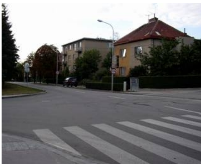
Obr. 2. Pohled na zařízení
