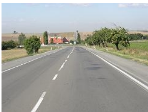
Obr. 10: Nedostatečně označená nebezpečná zatáčka (II/430 Vyškov-Brno)
