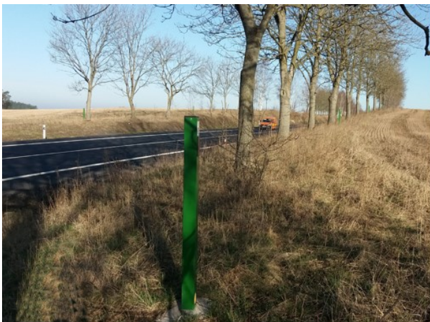
Kovové silniční směrové sloupky (realizace ze silnice I. třídy Karlovy Vary - Praha)
