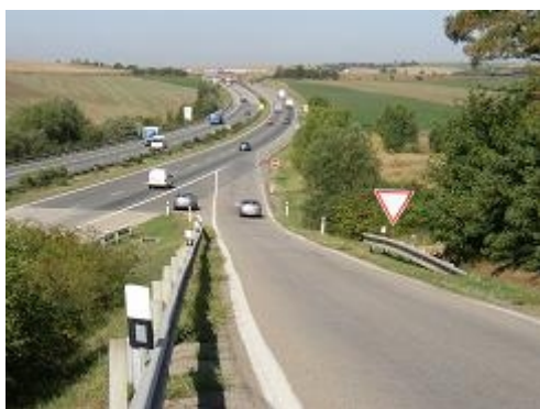
Obr. 11: Chybějící připojovací pruh (D 1, Rohlenka)
