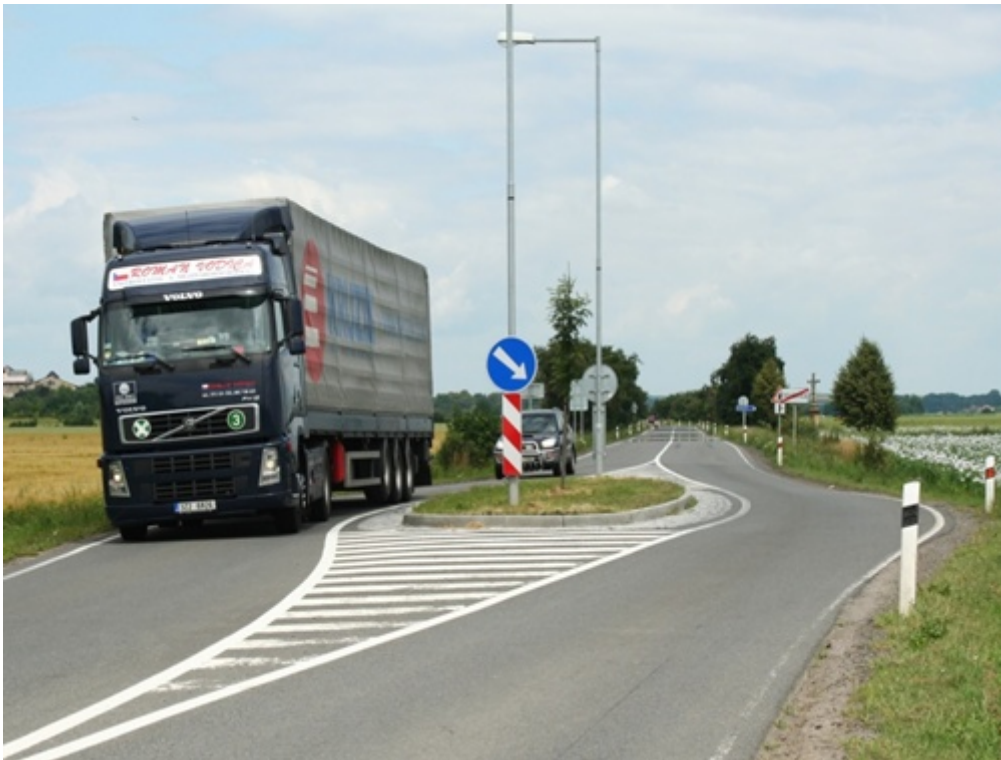
Obr. 2: Ochranný ostrůvek pro podporu přecházení – Prostějov.
