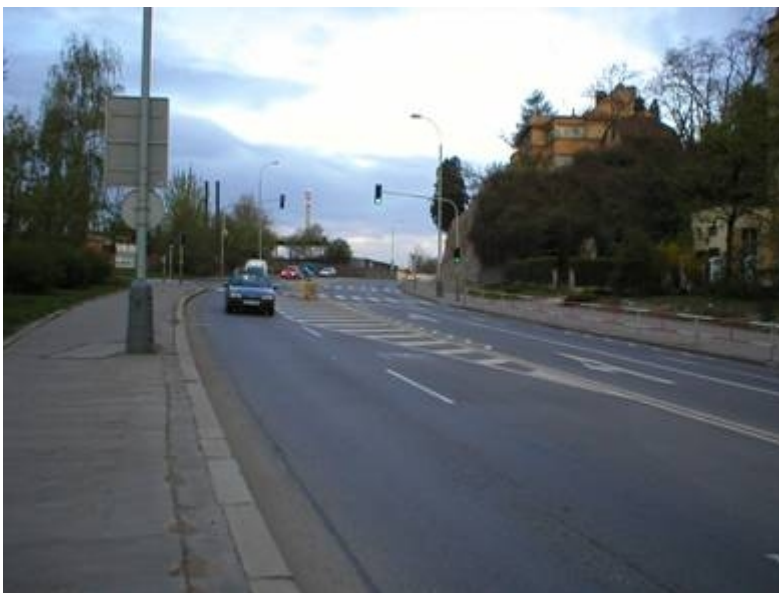
Obr. Pohled na zúžený čtyřpruh v místě přechodu
