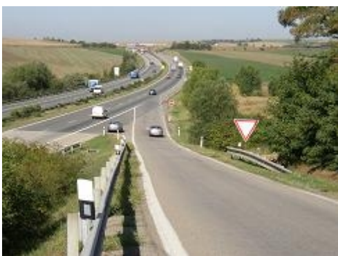
Obr. 11: Chybějící připojovací pruh (D 1, Rohlenka)
