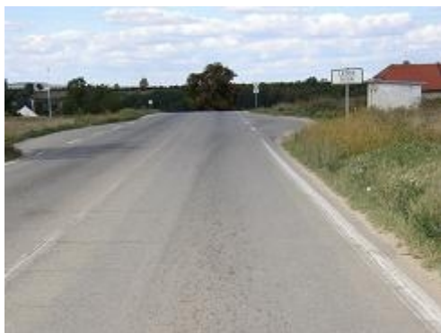
Obr. 9: Ztracená trasa - výškový zlom (stará I/52 Brno-Pohořelice)
