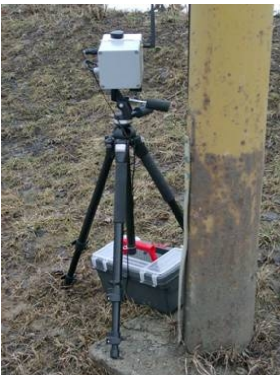
Obrázek 4 – Radar umístěný za sloupem veřejného osvětlení
