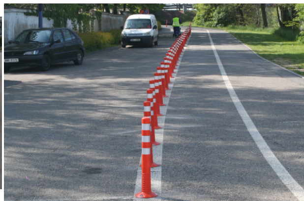
Obrázek 15. Benešov – po osazení (květen 2014)
